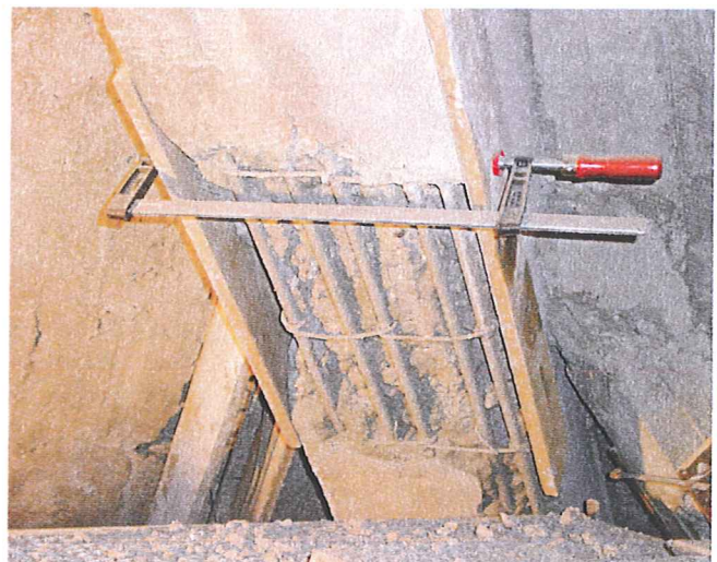
90 Nach dem Strahlen mit Feststoffen (Sandstrahlen) wurde die Bewehrung durch zweifache Beschichtung gegen Korrosion geschützt. Der mit Spritzbeton zu reprofilierende Bereich ist eingeschalt.
