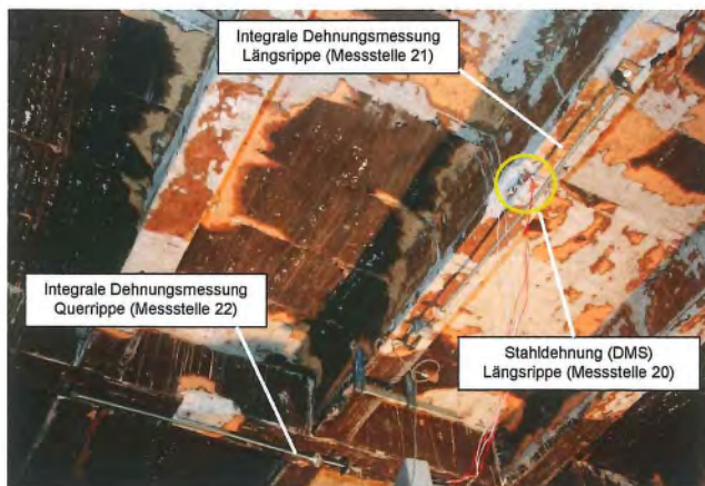
Abb. 20: Lage der Dehnungsmesspunkte an der Deckenunterseite
