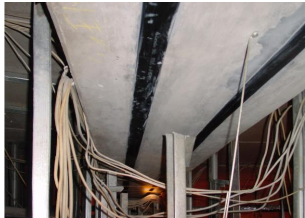
verstärkter Unterzug über Verkaufsraum
