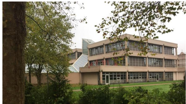
Ansicht Bestandsgebäude vor der Sanierung
