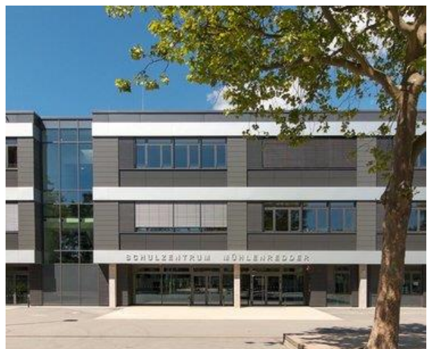
Ansicht nach der Sanierung
