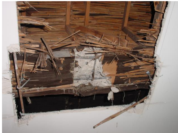
Bestandsuntersuchung, Bauteilöffnung einer Rippe
