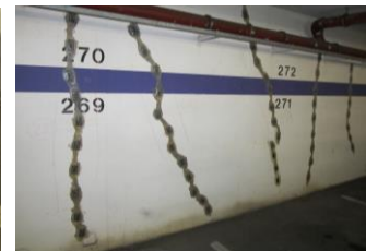
Potentialfeldmessung u. Rissverpressung Tiefgarage
