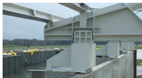
Lager der Dachbinder – Planung und Ausführung
